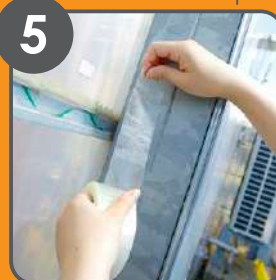
使用しない出入口を 目張り
