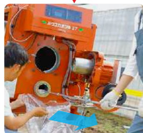
6 燃焼室内に溜まったすずをすずかき具でかき出す
