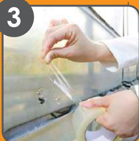
外張被覆の 目張り
