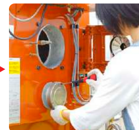
5 すず汚れに注意して掃除口を開ける
