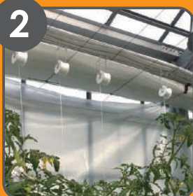
天井／側面カーテンの つなぎ目の隙間
