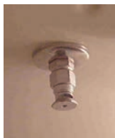
自動洗浄ノズル 使用前にシャワー室を 洗浄でき衛生的
