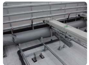
排ガスを利用したCO 2 施用
