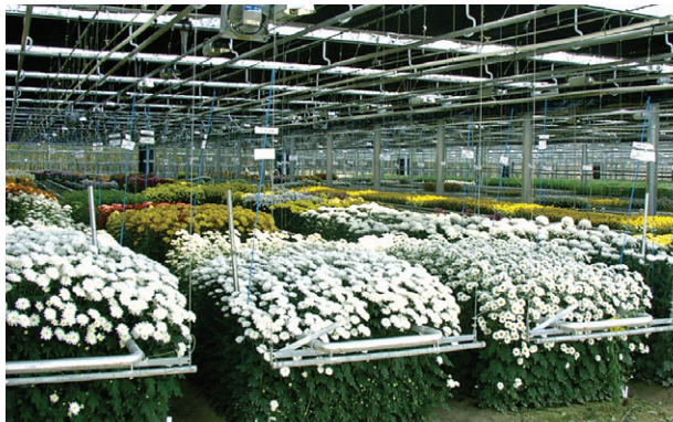
温室内 生長点・頭上暖房設備
