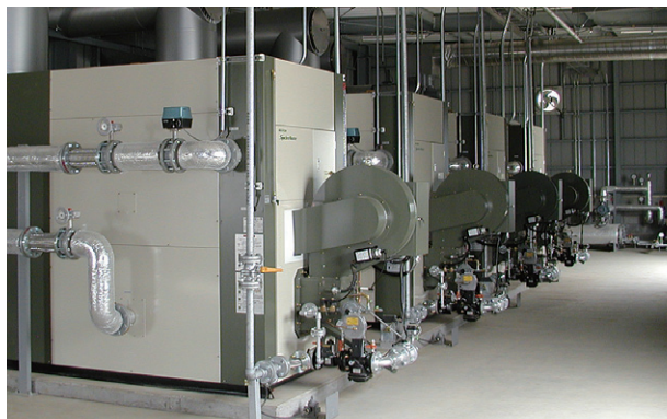
C棟用温水ヒータ：SBB-1002HL×4基
