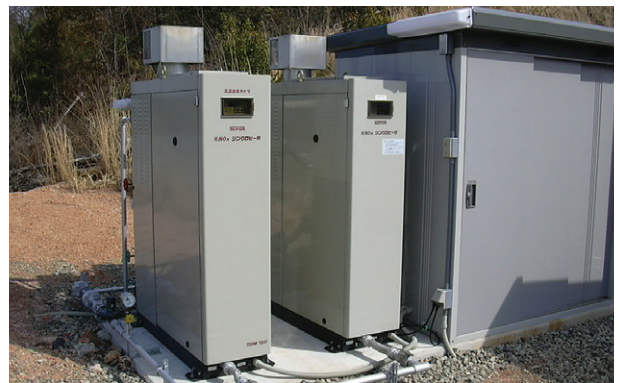
ベーパーライザ(燃料気化器)用ボイラ：SBM-150
