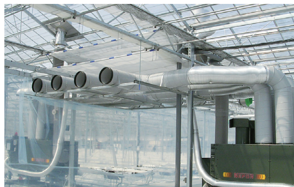
上吹きダクトによる温風吹出
