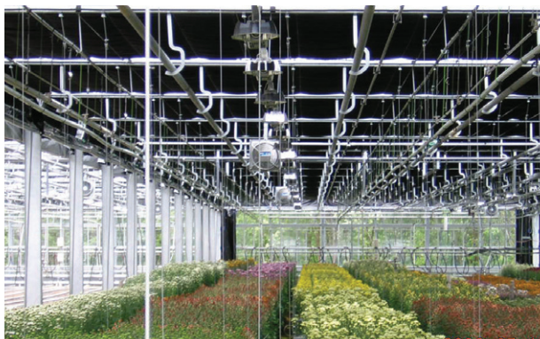
頭上暖房配管
