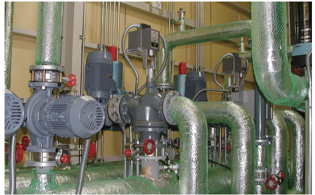
温水ヒータ：SBB-1001-3×2基
