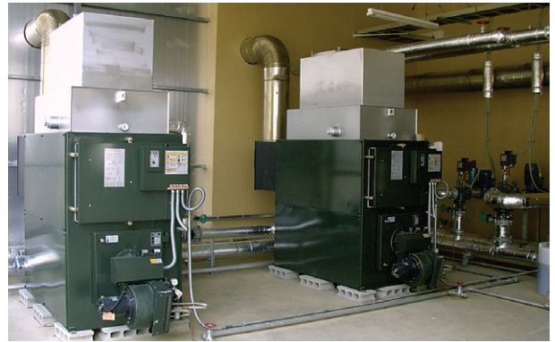
温水ヒータ：HB-4006TA(465kW)×2基
