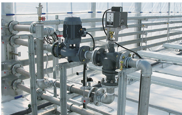
温室内ポンプユニット
