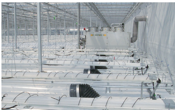
地下埋設ダクトによる温風吹出
