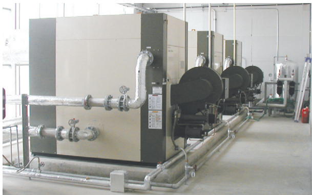
東棟 温水ヒータ：SBB-802HA×1基 SBB-1002HA×2基
