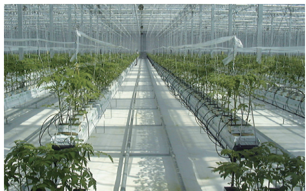
暖房用レール配管および炭酸ガスダクト
