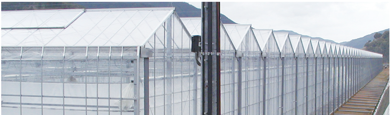
温室面積：1.25ha×2 高知県幡多郡三原村
