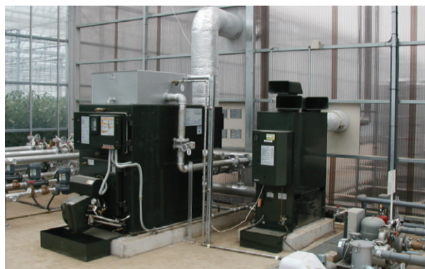
バット加温ボイラ：HB-2006TA 作業室暖房用温風機：KA-323E
