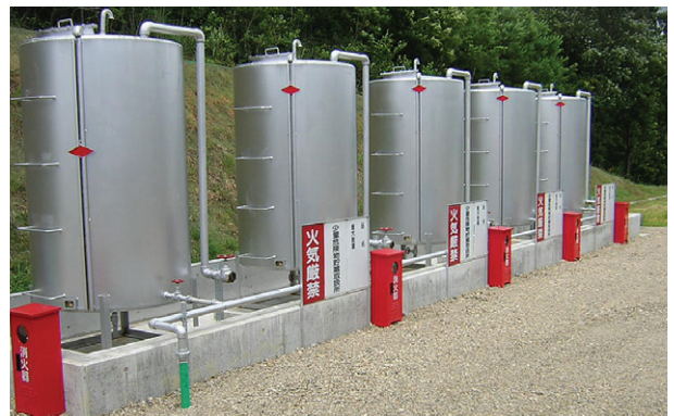
オイルタンク(A重油)1900L×5基
