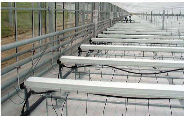
暖房配管・炭酸ガスダクト
