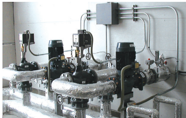
温水ヘッド・ポンプ類
