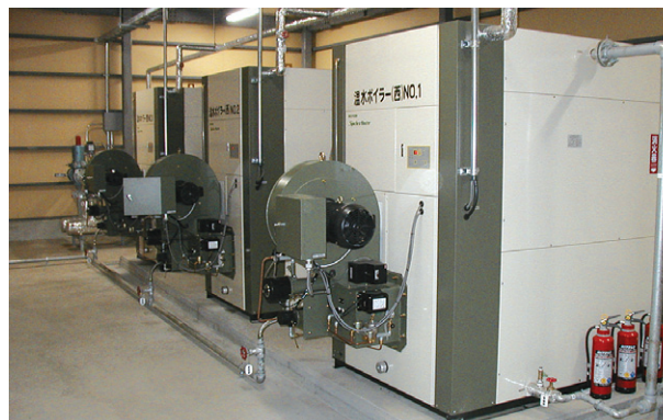
西棟 温水ヒータ：SBB-802HA×2基 SBB-1002HA×1基
