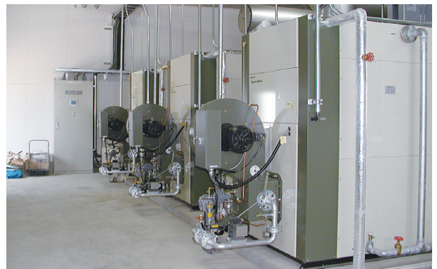
A棟用温水ヒータ：SBB-1002HL×3基
