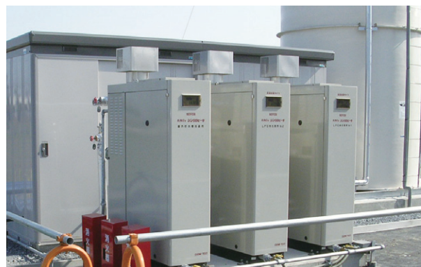
ペーパライザ(燃料気化器)用・水槽加熱用ボイラ：SBM-150
