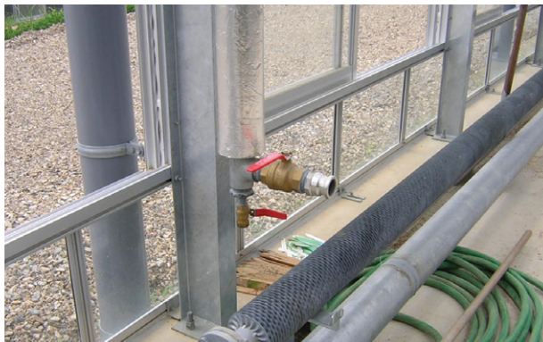
土壌消毒用蒸気配管
