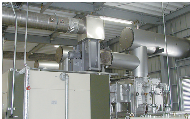
排気ガス回収炭酸ガス施用システム
