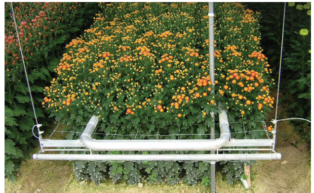
生長点暖房配管
